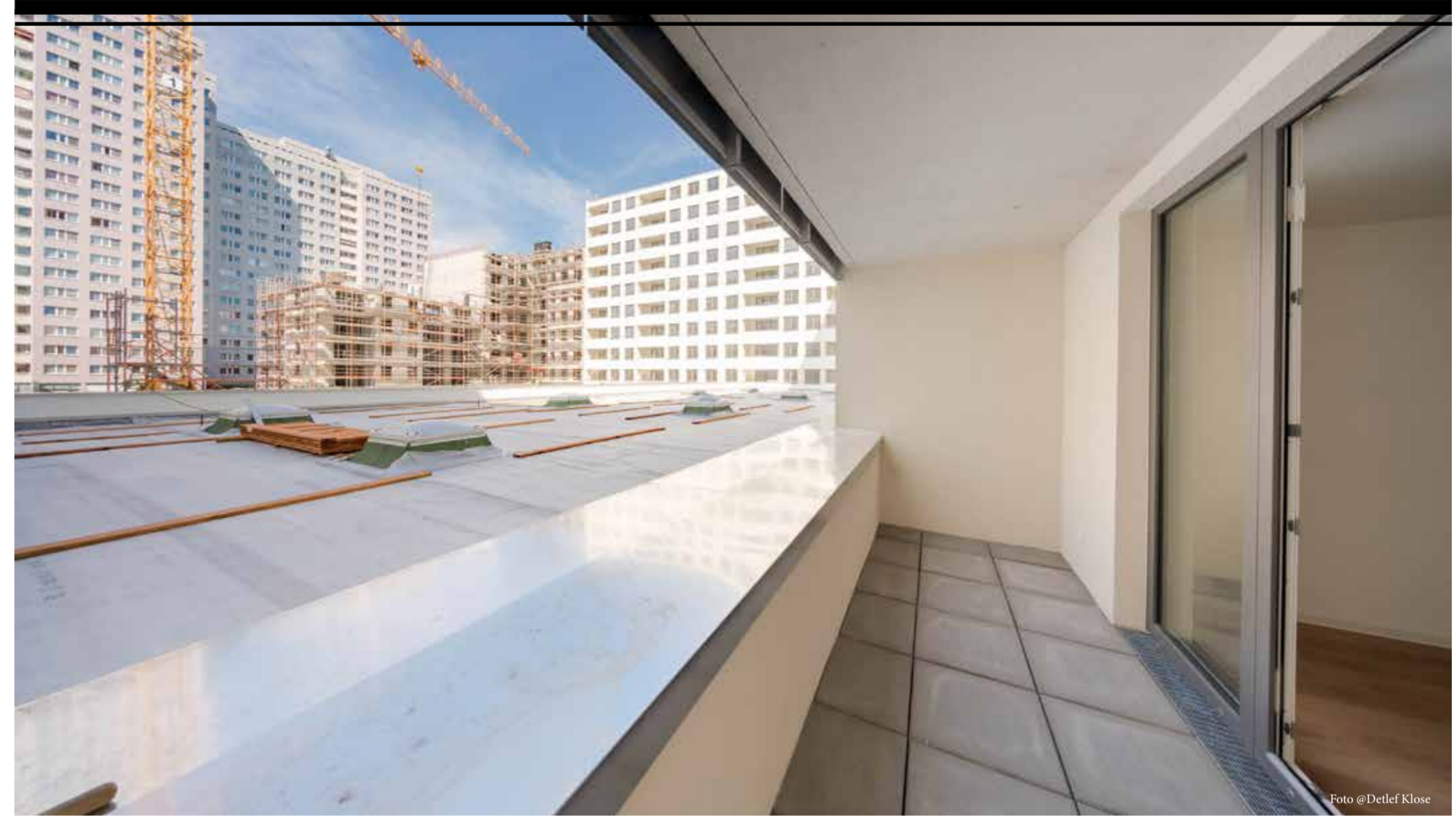
Alle 678 Wohnungen in der Anlage verfügen über großzügige Loggien.
